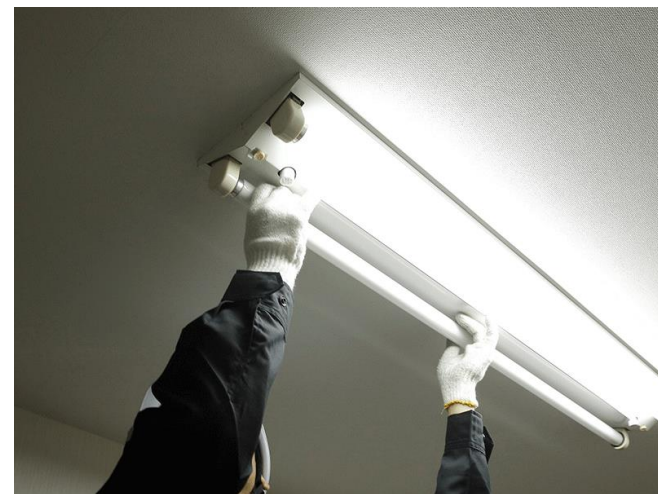
LED蛍光灯の設置工事
