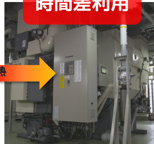
ジェネリンク (廃熱投入型ナチュラルチラー)
